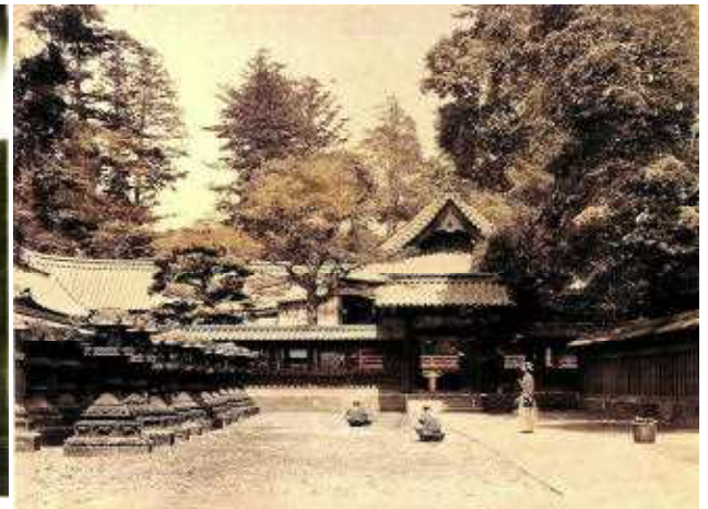
写真⑤仕切門
