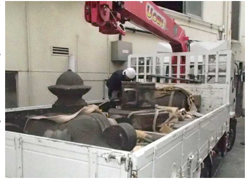
写真7 燈籠移設運搬作業 (写真提供：和田利一様)
