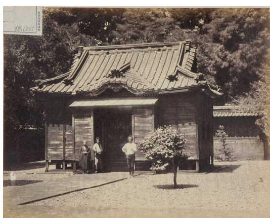
写真3 清揚院奥院拝殿
